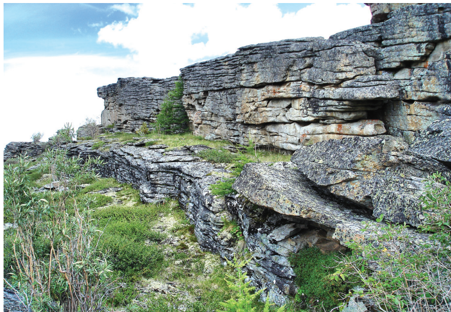
Фундамент дворцовых стен
